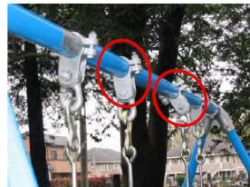
▲ 吊金具のずれ
