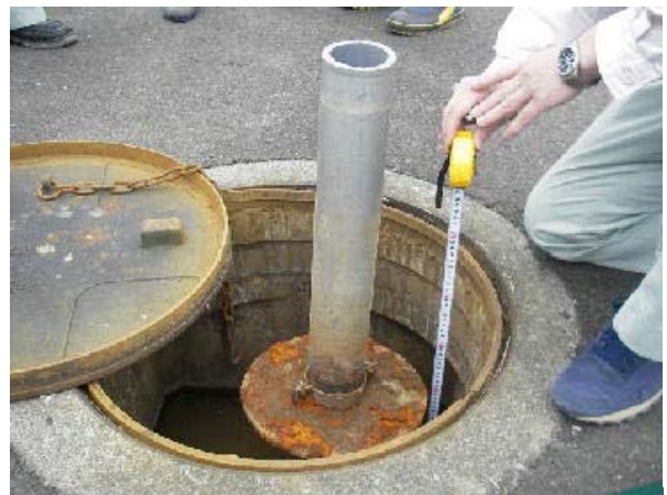
挿入パイプの突き出し
