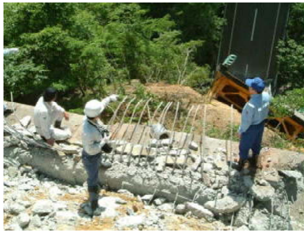
落橋した国道342号祭時大橋の状況(一関市)
