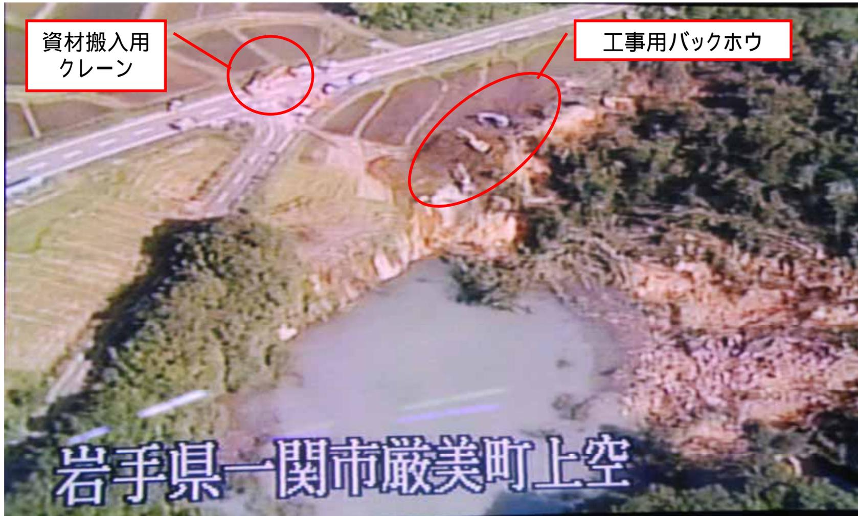
建設機械により仮排水路掘削のための準備として伐採中。
