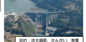
緑川ダム（S46年完成、治水容量2,400万m 3 ）
