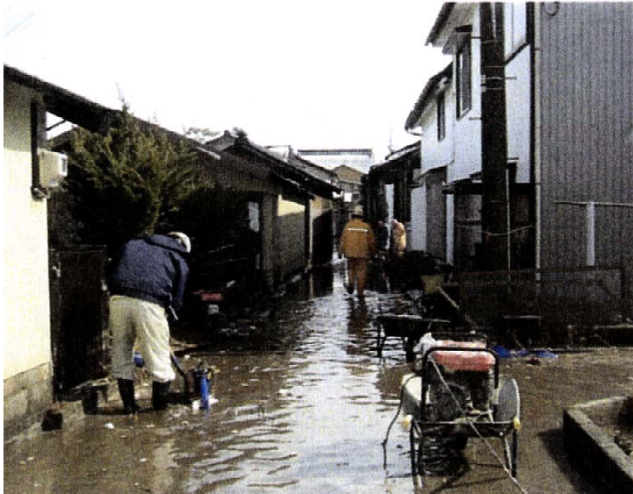
激しい越波により住家の破壊や浸水被害等が発生
