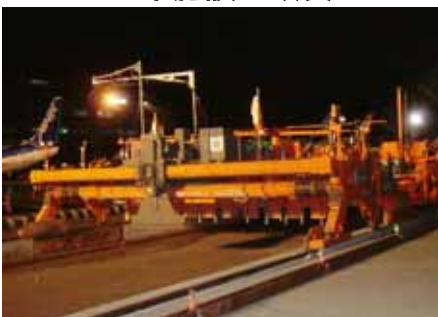
【エプロン舗装の改良】
