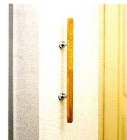
手すりの設置
