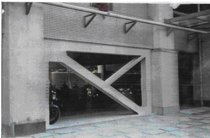
ピロティ階への鉄骨ブレース設置状況
