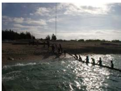
大型の係留施設のない離島における資機材・燃料等の陸揚げの様子
