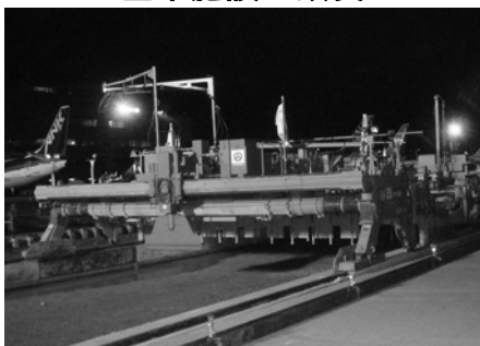
【エプロン舗装の改良】
