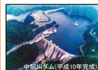
ダム高 73.1m 総貯水容量 1,260万m 3 洪水調節容量 860万m 3
