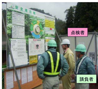
写真-2 点検状況（現場）
