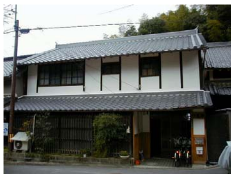
住宅の屋根・外壁に対する助成
