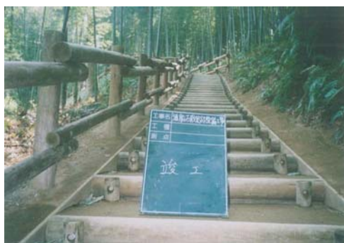
酒船石遺跡階段改修
