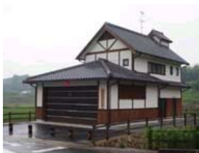
防災拠点施設地区（阪合地区）
