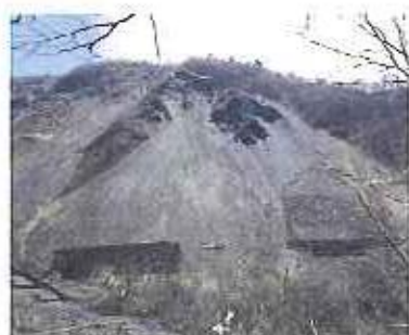
斜面崩壊が進んだ斜面 Eroded slopes.
