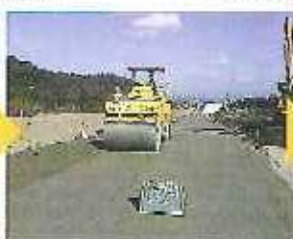
ソイルセメント締め固め Compacting soil cement
