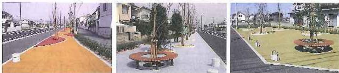
施工例 Example of construction
