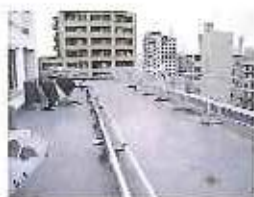
施工前状況 Before installation
