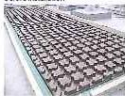
パネルの設置 Panel installation
