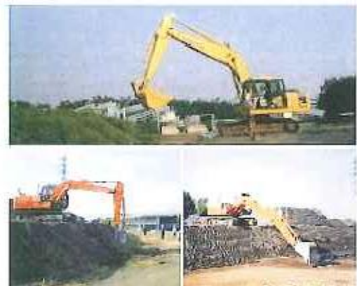
油圧ショベルの模擬編制作業イメージ Simulated operation image by hydraulic shovel
