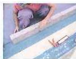
土留パネル Preparation of panel frame
