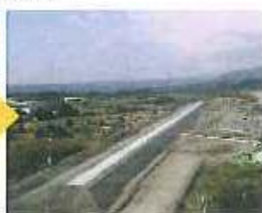
砂防堤完成 Completion of embankment
