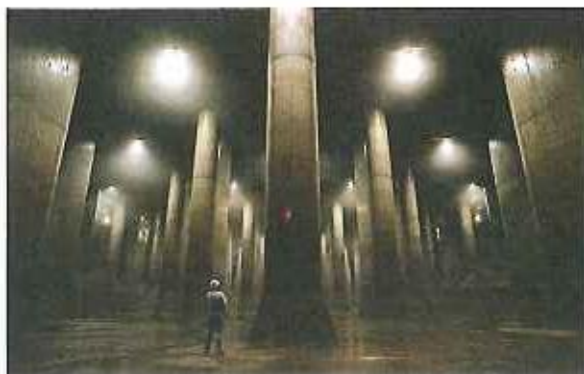
地下の貯水施設 Underground reservoir
