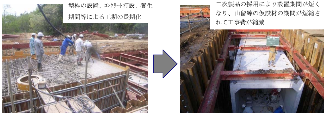
図 ボックスカルバート施工における二次製品の採用事例
