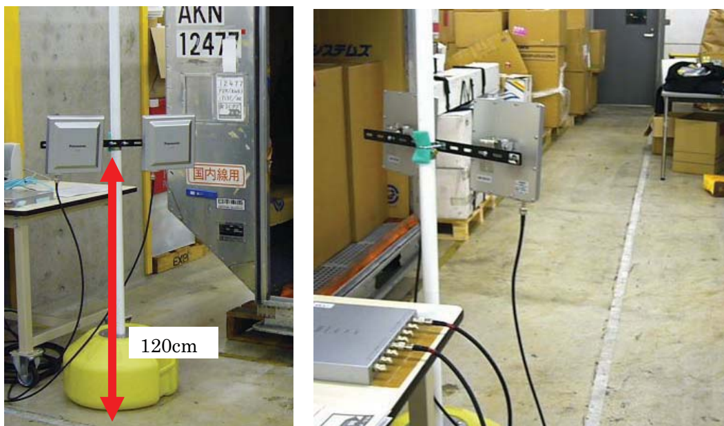
図 2-6 7 KLS 東京ターミナルにおける据置型 R/W 設置
