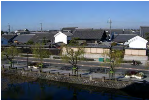
お城石垣から望む本町地区の街なみ。瓦葺の屋根と塀で構成された景観が見られる。出入り口や窓が殆どなくお城との関係が現れている。
