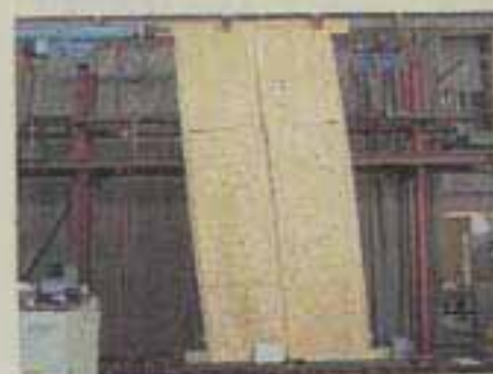
写真4 高さ4000mmの面材試験体の破壊状況
