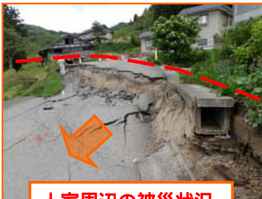
人家周辺の被災状況
