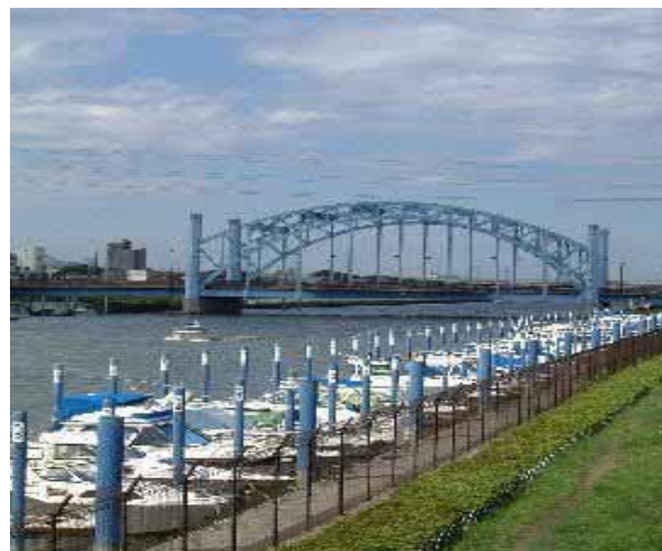
河川の暫定係留施設の整備事例(新中川)
