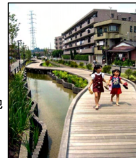
下水処理水を活用したせせらぎ整備(神奈川県川崎市)
