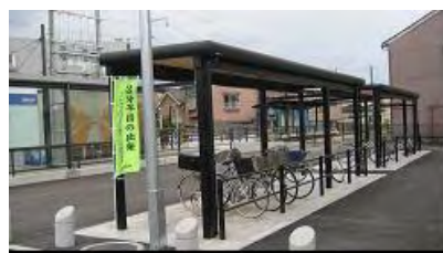
■写真 3.2.4 各電停に駐輪場整備(地域生活基盤施設)
