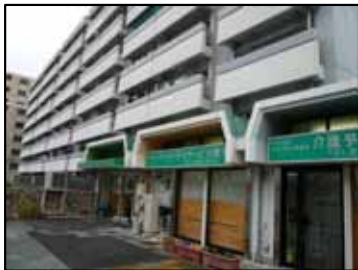
鳴子団地内の活動拠点
