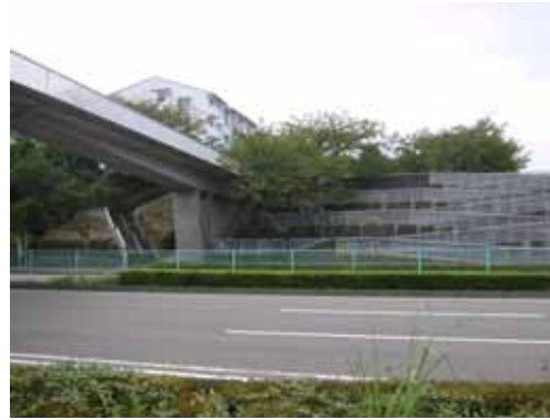
長い急勾配スロープ(勾配1/10)
