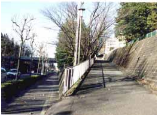
バス停と住宅地を繋ぐスロープ
