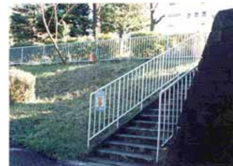
敷地内随所にある階段
