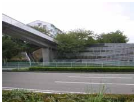
長い急勾配スロープ(勾配1/10)
