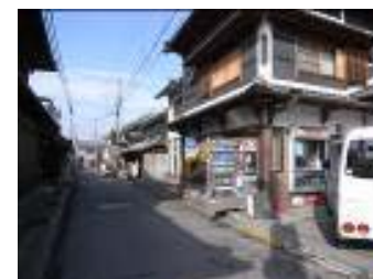
伝統的な街並みにおける電線・電柱
