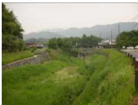
飛鳥川護岸整備
