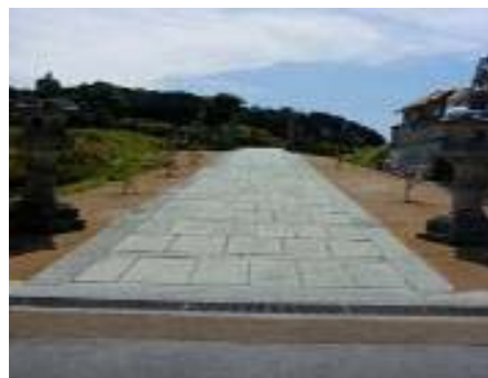
散策路整備(橘寺西門)
