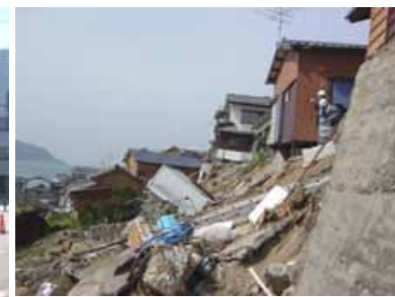
写真: 福岡県西方沖地震
