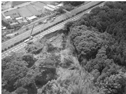
【駿河湾を震源とする地震(H21.8.11)による東名高速の被害状況】
