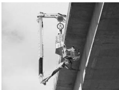
【橋梁点検の例】
