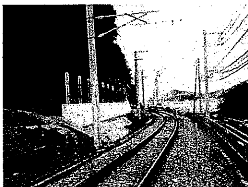
【落石防止擁壁の一例】
