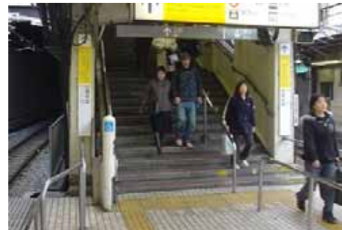
階段・ホーム幅とも狭隘で、エレベーターの導入空間を確保できない例
