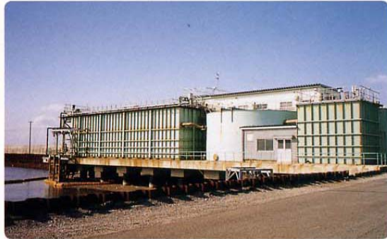
排水処理施設
