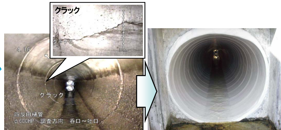
函渠内面からの補修（新技術）
