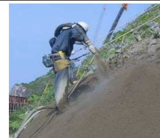
ローピングウォール 施工状況
