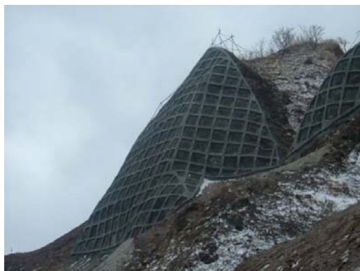
従来：現場吹付法砕工
