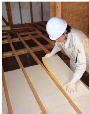
床の断熱工事
