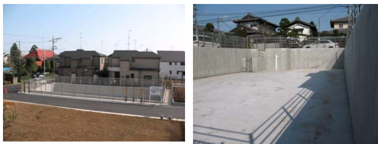
〈雨水貯留浸透施設の例〉
