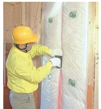
壁の断熱工事
