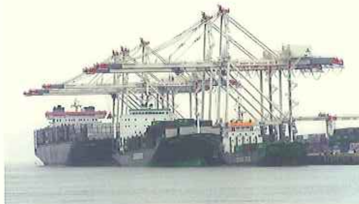
■外貿コンテナターミナル
