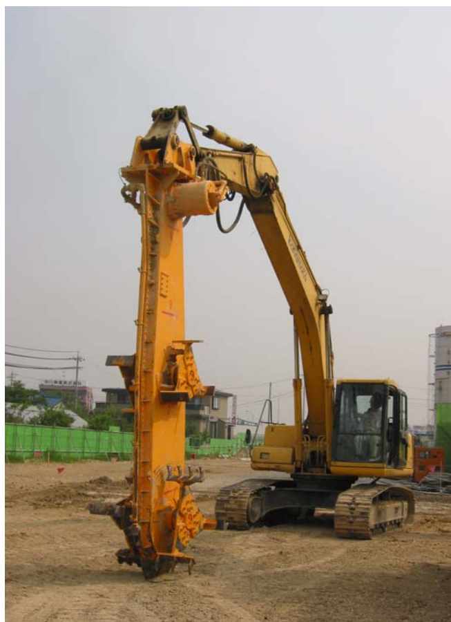
写真一 1 SCM 施工機 (ロータリーブレンダー方式)
