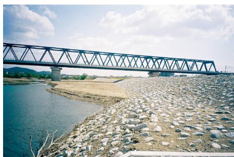
写真—4 施工直後写真(加古川)
