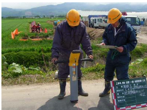
写真-3 ロケーティング状況
