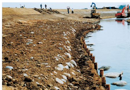
写真—6 施工直後写真(姿川)
