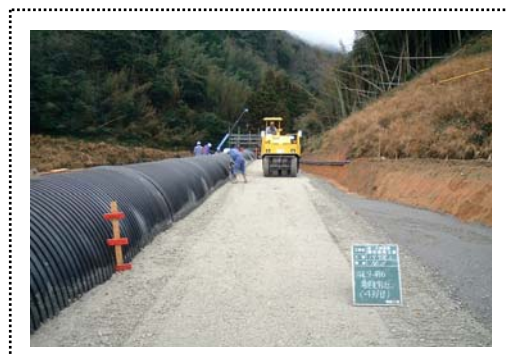
写真—2 締め固め状況
