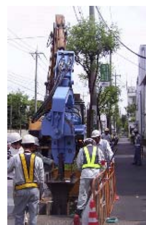
写真一 2 打設状況
