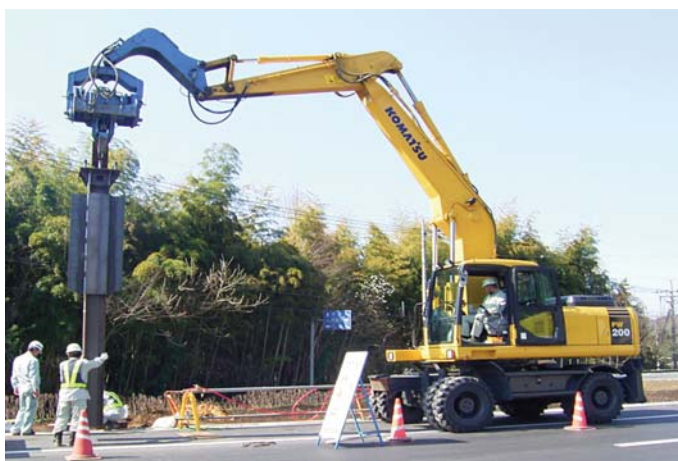
写真一 1 専用杭打機による施工状況
