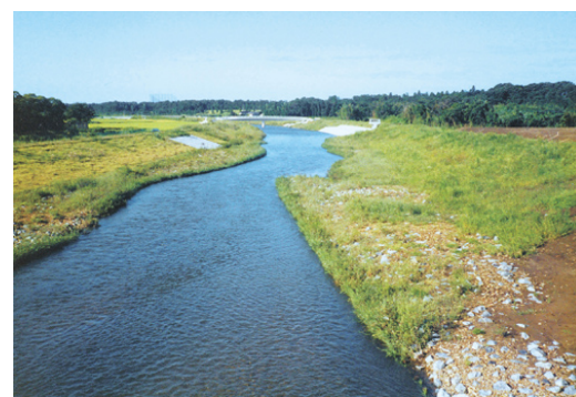
写真—7 施工5ヶ月後写真(姿川)
