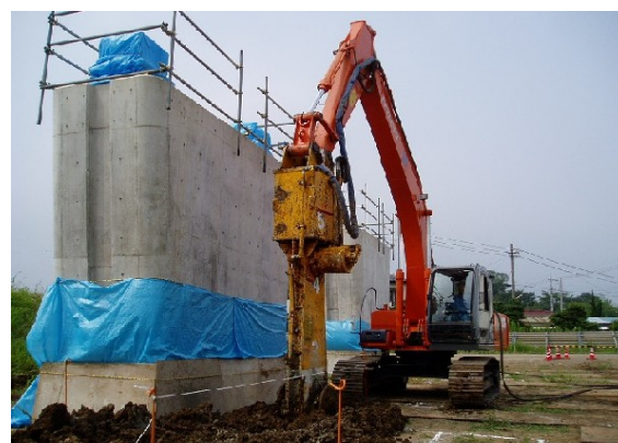
写真一 3 近接施工例
