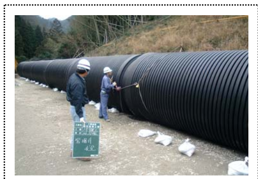
写真—1 接続作業状況
