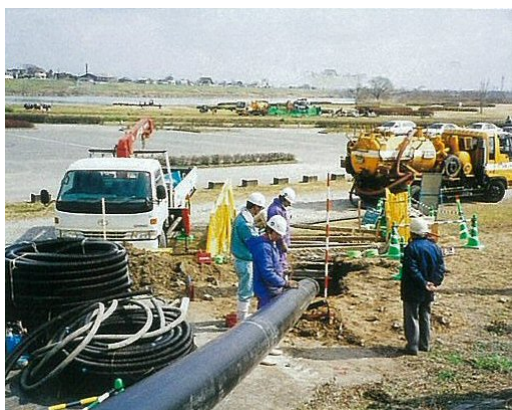
写真-4 φ300mm管引込状況
