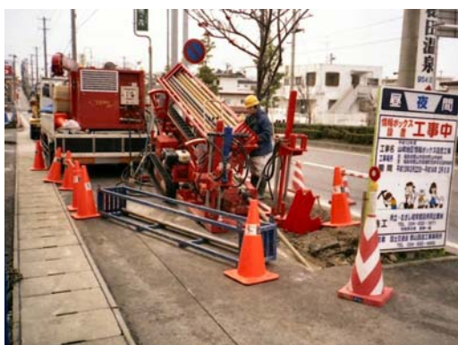
写真-2 テラジェット据付状況
