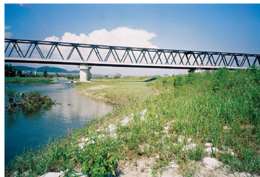
写真—5 施工半年後写真(加古川)
