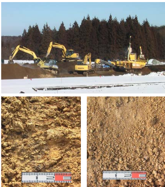
写真一 1 道路改良工事での稼働事例 上段： 盛土工区近くで稼働中のリテラ 下段： 左：原料土 右：改良土
