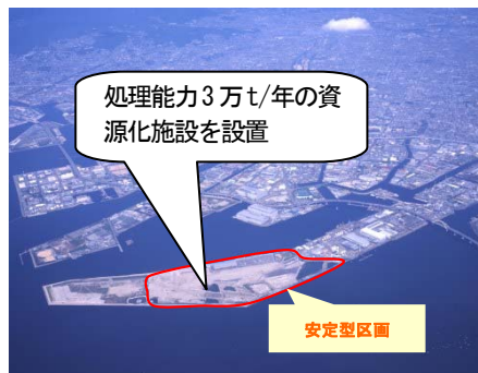
写真-1 尼崎沖埋立処分場
