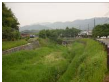
飛鳥川護岸整備
