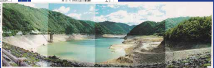
牧尾ダム 平成6年8月12日(金)撮影 0時現在貯水量4.9億m 3 堤体右岸部から上流部
