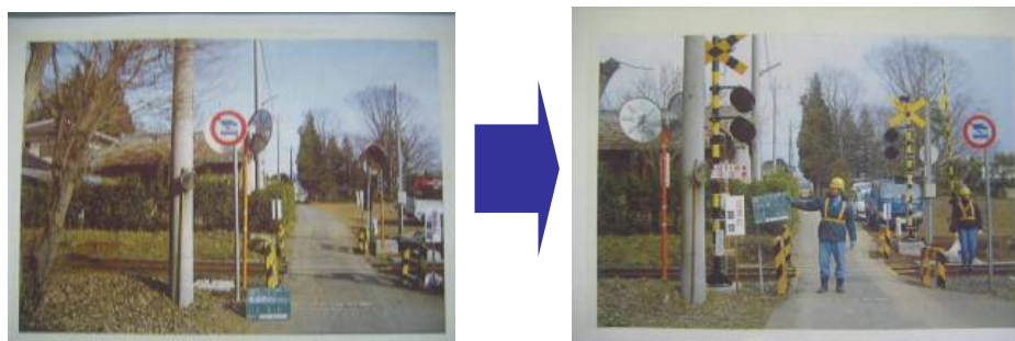
図1:踏切遮断機・警報機の整備
