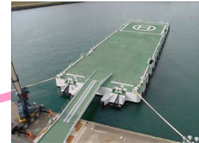
広域防災フロート
