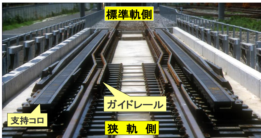
軌間変換装置（地上側）
