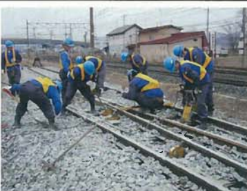
バラスト突き固め (分岐区間)
