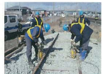
バラスト突き固め (一般区間)
