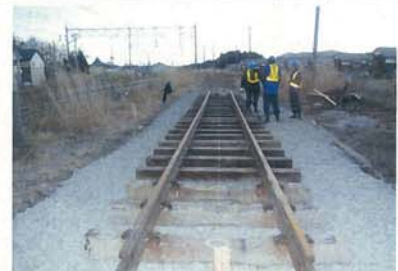
レール&マクラギ設置
