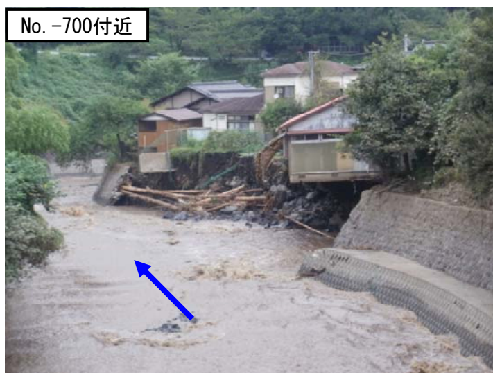
落差工下流における護岸倒壊
