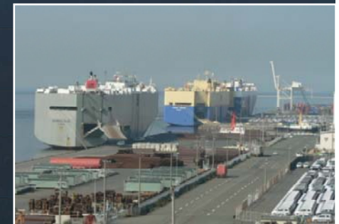
【神野地区】 完成自動車荷役状況
