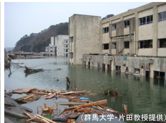
津波によって浸水した鵜住居小学校(手前)と釜石東中学校(奥)
