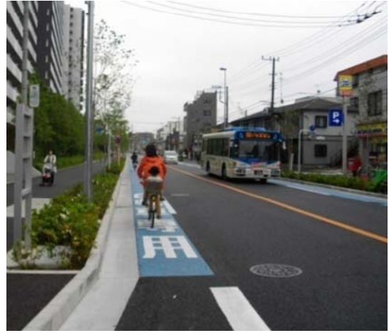
しん かわさき きた かせ おぐら 新川崎地区 市道北加瀬60号・小倉18号線 (神奈川県川崎市)
