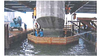
尾竹橋耐震補強工事施工状況
