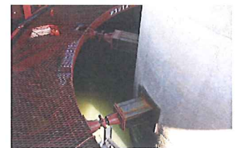
支保工を兼用した足場
