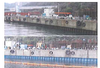
IHI 相生工場 第 13 岸壁防食工事 施工前(上) 施工後(下)
