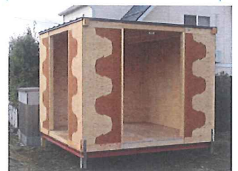
北誠スーパーウッドテクノ工法で施工した耐震シェルター
