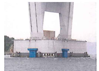
瀬戸大橋 HB2P 橋脚鋼ケーソン防食工事
