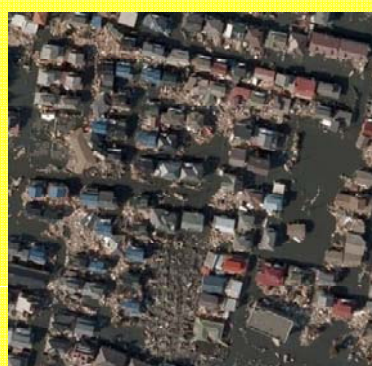
②建築物の多くに流出や損壊が見られる
