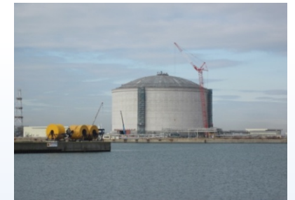
石狩LNG受入基地建設状況
