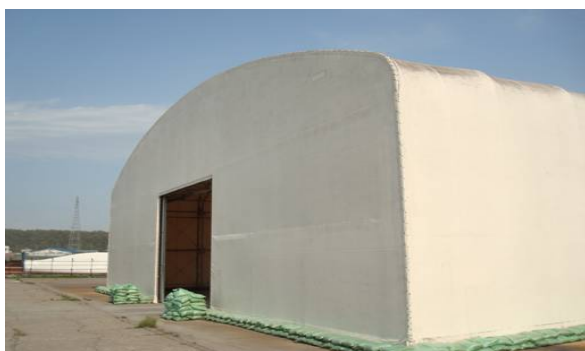
【仮設テント倉庫】
