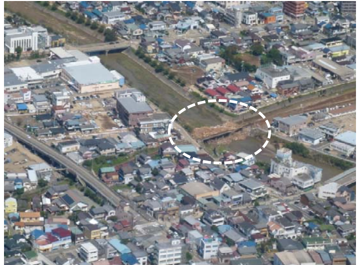
三重県 井戸川 鉄道橋 流木による河道埋塞
